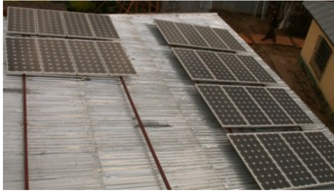
Gambar 11.1: 24 panel surya dengan daya nominal 80 W telah terpasang di atap NOC untuk menyediakan daya untuk sistem 24 / 7.
