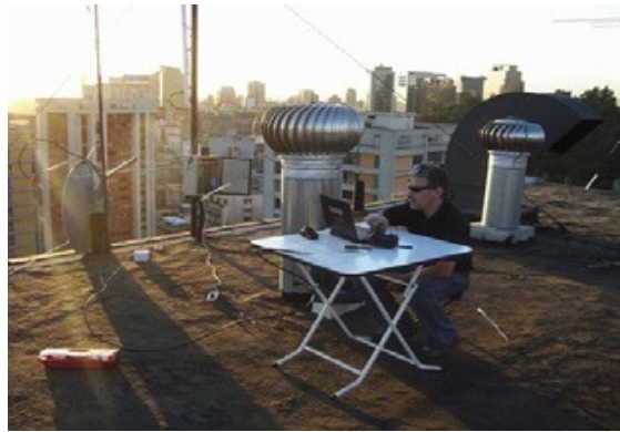
Gambar 11.23: Node di downtown terhubung ke node di selatan Santiago. Perhatikan antena Parabolic untuk backhaul dan slotted antena untuk menghubungkan klien.
