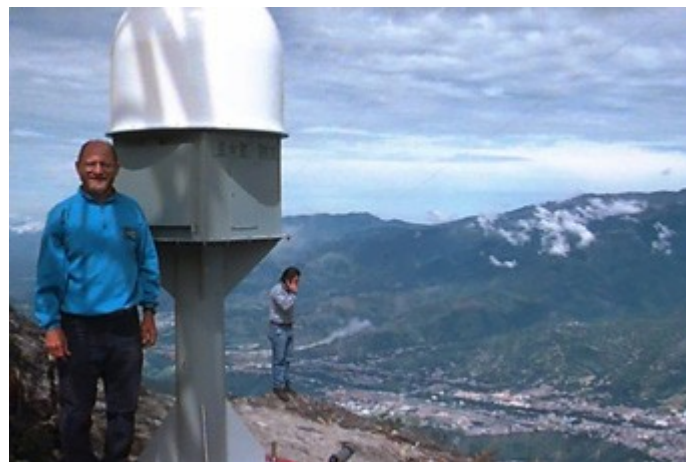
Gambar 11.12: Instalasi di atas Mérida pada La Aguda, pada 3600 meter.
