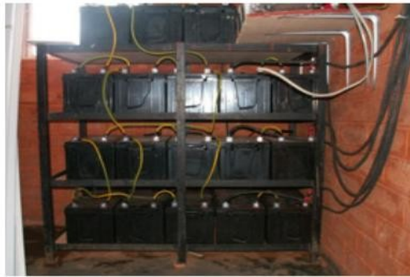
Gambar 7.9: bank baterai 3600 Ah, arus mencapai tingkat 45 A selama penyimpanan daya
