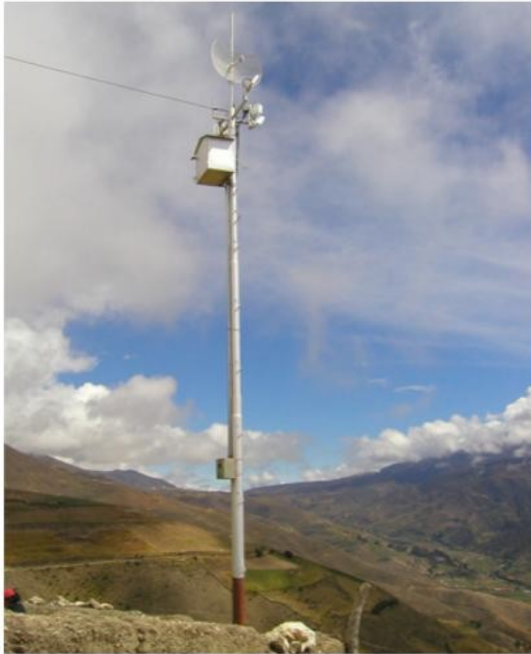
Gambar 8.3: menara self-support yang sederhana
