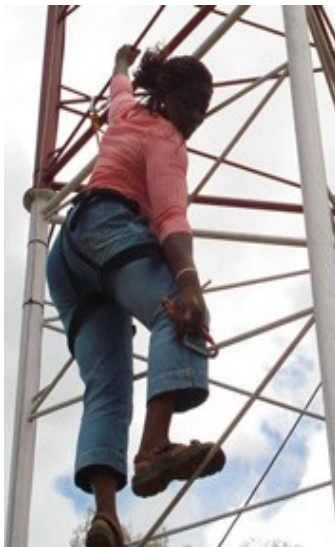
Gambar 11.3: Omolayo Samuel, salah seorang staf Zittnet, tidak takut pada ketinggian di menara 45m saat dia mengarahkan antenna yang terdapat di atap menara.
